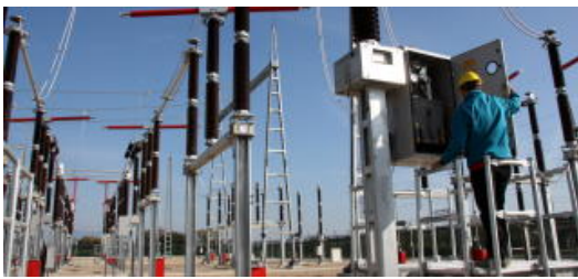
Posen en tensió el tram aeri de la MAT entre Bescanó i Santa Llogaia d'Àlguema
