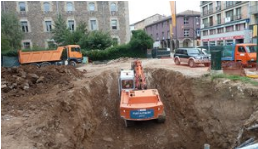
Un detall de les obres de construcció de la sortida del pàrquing pel parc dels Coloms. Foto: J.C.
