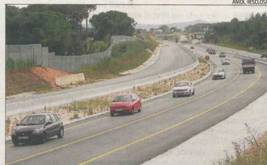
El tram entre Sils i Caldes ja es troba en fase de desdoblament.
