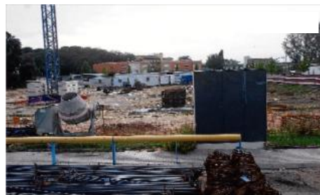
Una imatge d'ahir de la construcció de l'escola Benaula al fins ara pati de l'institut en barracons (al fons). carles colomer
