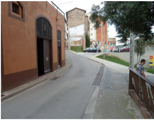
Una vista de l'exterior de la capella de la Verge del Portal, recentment pintada. Foto: J.C.
