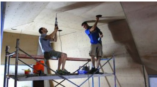
Un moment dels treballs que s'estan portant a terme a l'antic escorxador d'Arbúcies. Foto: EL PUNT AVUI.
