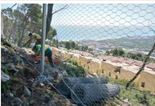
Operaris instal·lant un dels trams de malla metàl·lica per contenir esclavissades Foto: EL PUNT AVUI.
