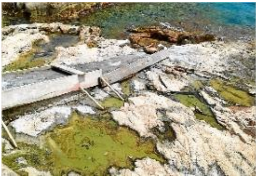
Una passera construïda des del camí de ronda fins al mar.
