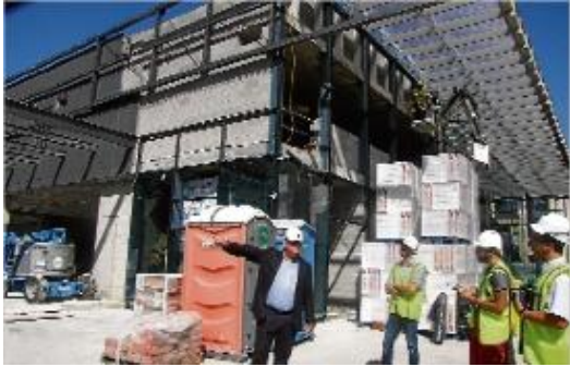
Josep Maria Corominas a la plaça Mercat visitant les obres.
