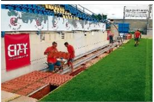
Uns operaris tapen el fossat que envolta el camp
