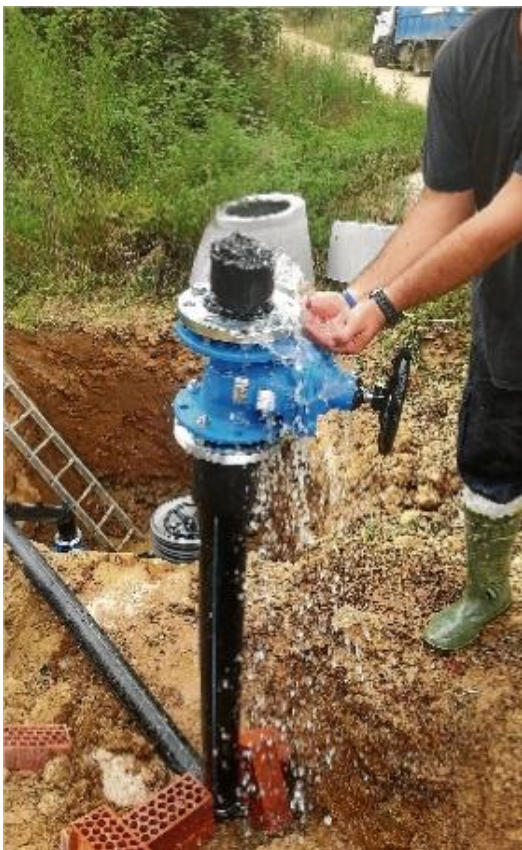
Dues imatges dels treballs de la interconnexió que l'Ajuntament de Vidreres està fent al terme de Llagostera.
