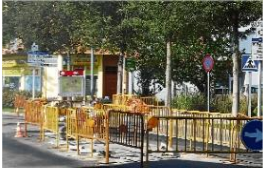
Un moment de les obres de construcció de zones segregades.
