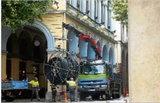
Descarrega de cable de fibra òptica a la plaça Clarà.
