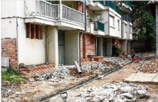
Les obres d'urbanització van començar fa pocs dies.
