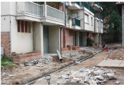
Els treballs en un dels carrers que s'estan millorant. Foto: AJUNTAMENT DE S. JOAN DE LES ABADESSES.
