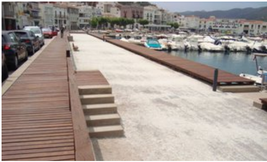
El passeig de fusta portuari de Port de la Selva ja amb les millores realitzades. Foto: EL PUNT AVUI.
