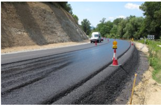
Al tram del pou del glaç ahir s'hi feia l'asfaltatge Foto: J.N.
