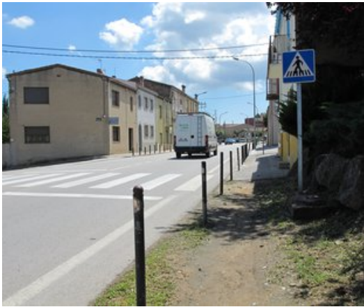
Les actuacions consistiran en la millora del ferm, voreres, serveis i senyalitzacions Foto: J.N.
