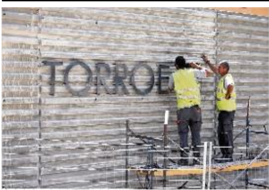
Nova estació de bus a Torroella
