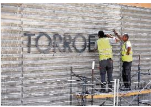
Nova estació de bus a Torroella
