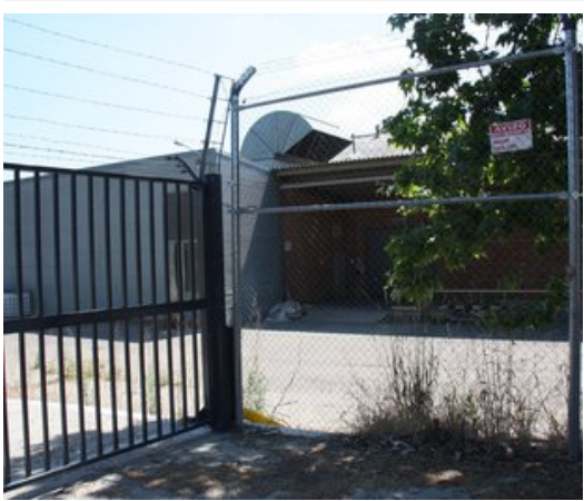
La zona de la nau de la Gasol on va passar l'accident. Foto: NEREA GUIASOLA/ ACN.
