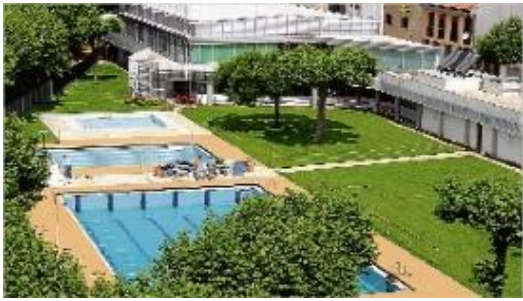
Imatge de les piscines municipals d'Arbúcies en plena remodelació.
