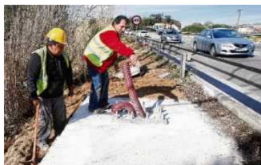
Operaris instal·lant aquest febrer el cablejat del radar per tram entre Cassà i Llagostera a la C-65. marc marti
