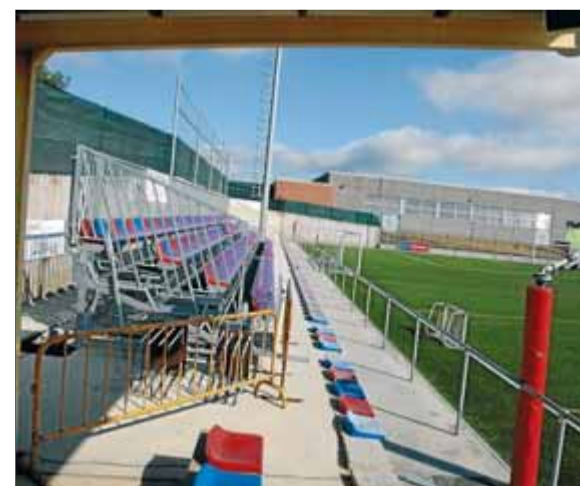
A la foto, un moment de la instal·lació de la coberta de tribuna l'estiu passat ■ J. SABATER
