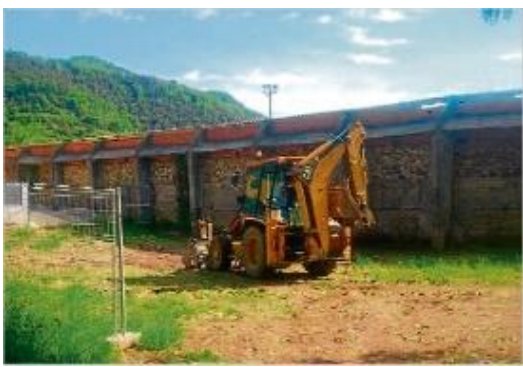
Comencen les obres del nou edifici de serveis
