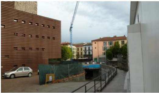
Una vista general del sector de l'illa del Teatre, on es duen a terme les obres Foto: J.C.
