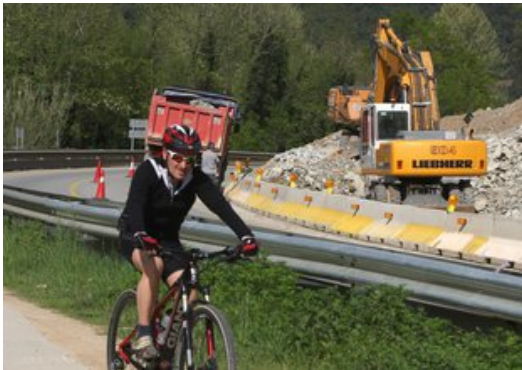
Les obres de millora a la carretera N-141e, a tocar del carril bici. Foto: LLU S SERRAT.
