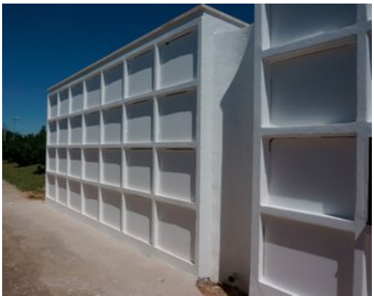
Els nínxols nous que s'han aixecat al recinte funerari de Torroella de Montgrí Foto: EL PUNT AVUI.
