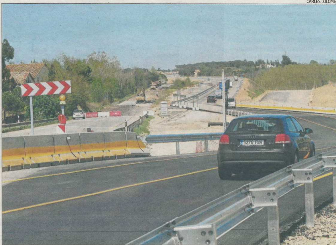
Les obres de desdoblament de la N-II entre Sils i Caldes encara no estan acabades.
