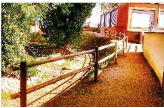
Les obres del passeig del Torrent Vidal, acabades.
