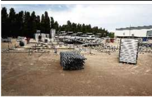
Un moment del muntatge de l'estructura per al concert central.
