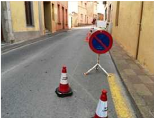
Obres al carrer Sant Feliu de Llagostera
