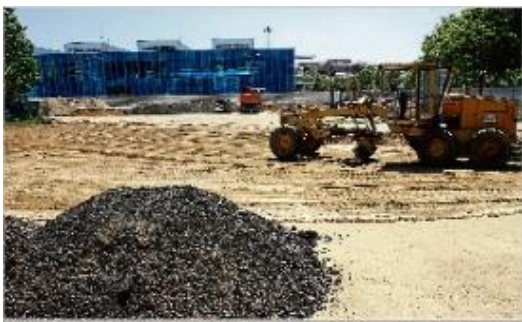
Imatge dels treballs a l'aparcament, que ara disposarà de 150 places.
