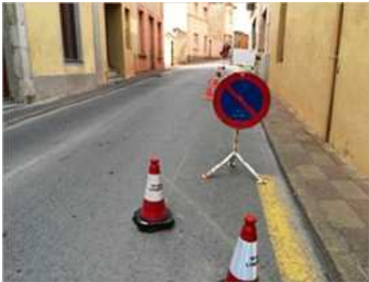
Obres al carrer Sant Feliu de Llagostera
