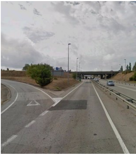
Aspecte parcial de l'enllaç de l'A2 al terme municipal de Vidreres, que el Ministeri de Foment remodelarà. Foto: EL PUNT.
