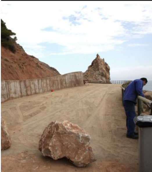
Un operari repassa la tanca exterior de la zona del Molinet. Foto: JOAN SABATER.
