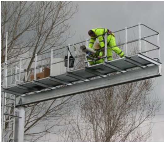
Uns operaris treballant al radar de la C-65, a Cassà Foto: Ò. PINILLA.
