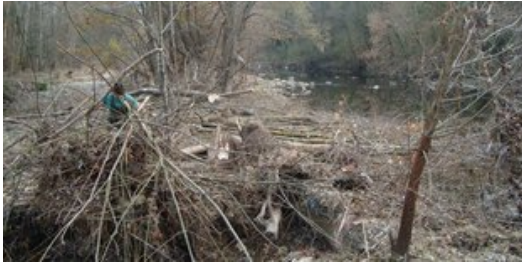
Un operari treballant als marges del riu Fluvià al terme d'Argelaguer. Foto: CONSELL COMARCAL DE LA GARROTXA.
