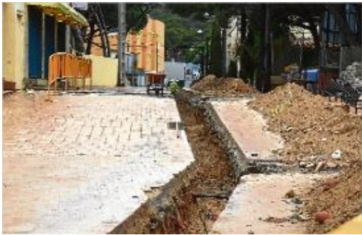
Les obres que s'estan portant a terme a Montgó.
