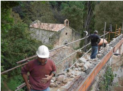
Un moment de les obres en els murs exteriors de l'antiga rectoria, la tardor passada. Foto: JOSEP VILAR.
