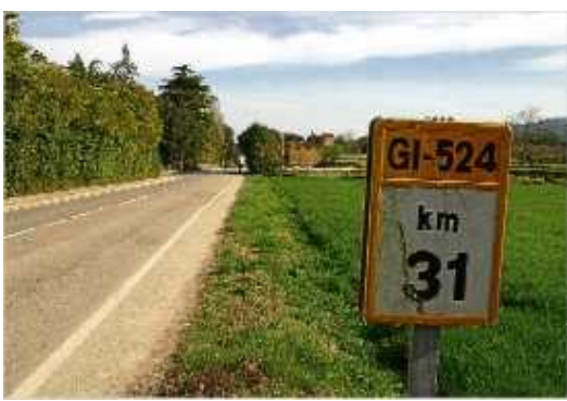
Millores a la carretera de Sant Miquel
