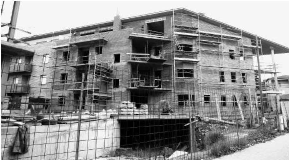
Un dels nombrosos blocs de pisos que s'estan construint a la ciutat de l'estany. / EUDALD PICAS.
