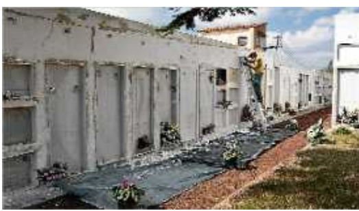
Els treballs afecten sobretot l'arranjament de parets dels nínxols.
