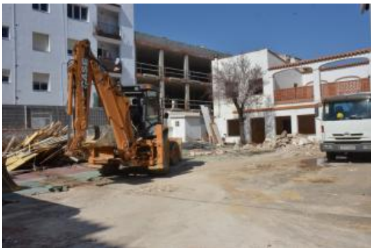
Les màquines treballen a Ca les Monges per fer l'enderroc
