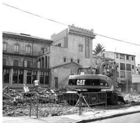
La màquina que treballava aquestes dies a L'Art Cristià. / J.C.
