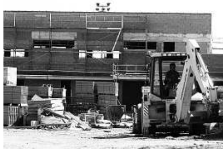
► Sense carrers pel mig. Les obres de la nova escola de Peralada es preveu que s'acabin a finals d'aquest any. El nou edifici evitarà que els alumnes hagin de travessar un carrer per anar d'unes aules a les altres, com passa a l'actual centre educatiu. / LL. SERRAT
