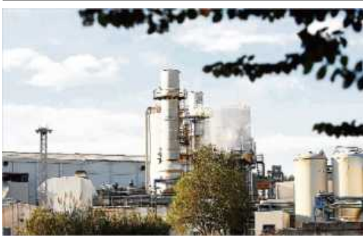
Instal·lacions de Torraspapel a Sarrià de Ter.
