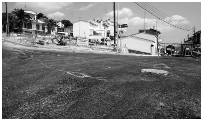
Un dels punts de la urbanització on encara falta una altra capa d'asfalt. / JOAN SABATER
