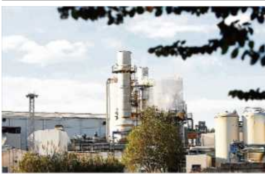
Instal·lacions de Torraspapel a Sarrià de Ter.
