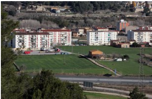
Blocs de pisos al barri de la Rasa, a Sarrià de Ter
